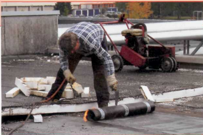
Bild 2: Schweißarbeiten auf dem Dach.
